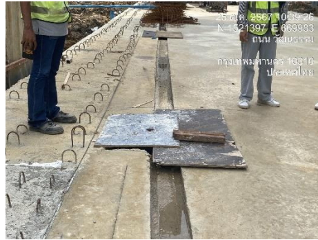
รูปที่ 47 รางระบายน้ำภายในโครงการ
