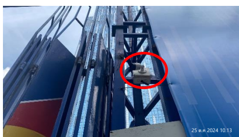
รูปที่ 49 ติดตั้งกล่องวงจรปิด
